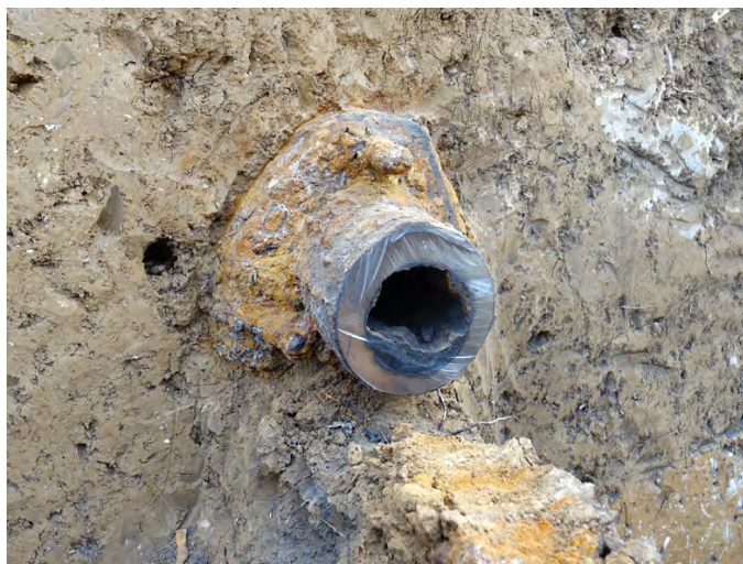
Fig. 71 : Coupe de la canalisation en fonte St 4 © C. Travers
