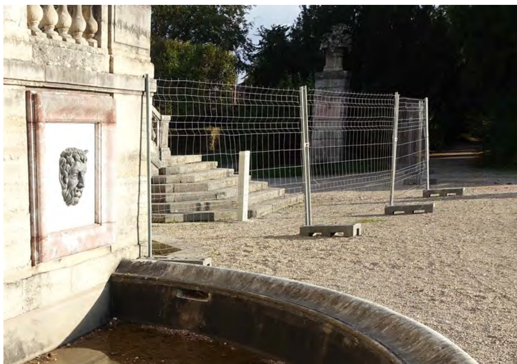
Fig. 5 : Barriérage du chantier autour du Pavillon de l'Aurore © C. Travers
