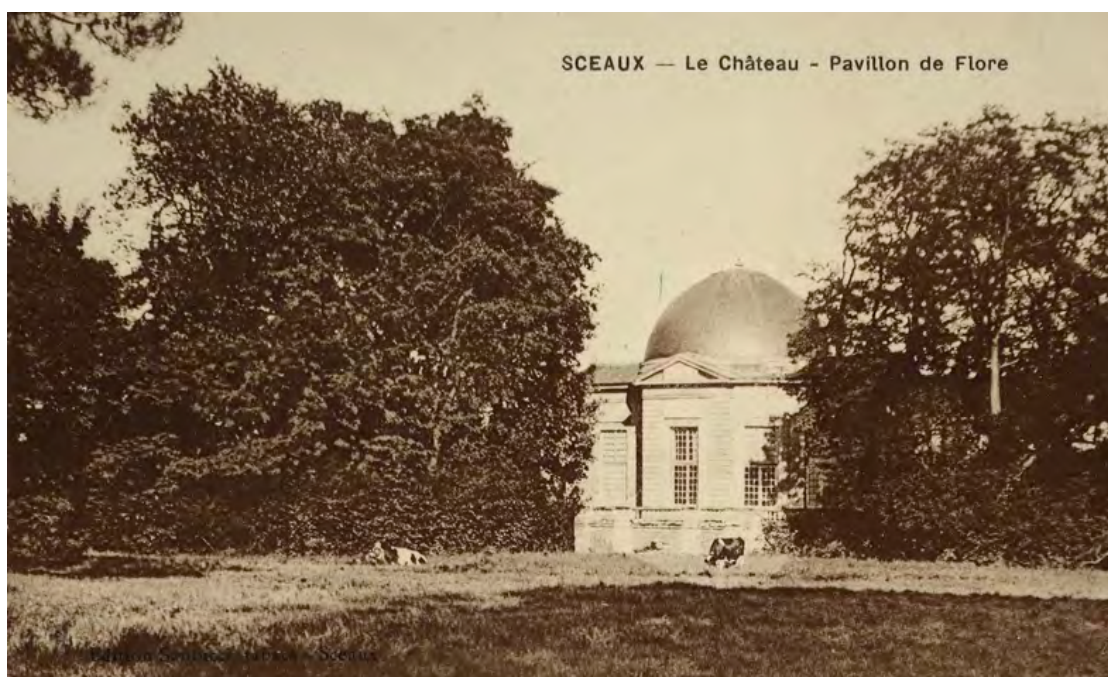
Fig. 35 : Des vaches dans le jardin du pavillon de l'Aurore - « Sceaux - Le Château - Pavillon de Flore », Carte postale, début XXe, AD 92, 9FI/SCE_151 © Archives Départementales des Hauts-de-Seine
