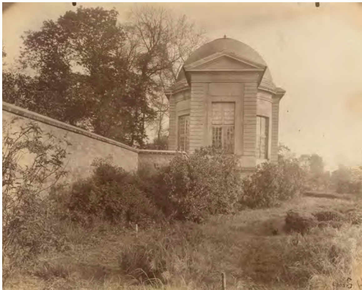
Fig. 38 : Le mur construit par Lecomte au sud du pavillon - Parc de Sceaux , photographie, Eugène Atget, 1925-1927 - Coll. Bibliothèque Nationale de France
