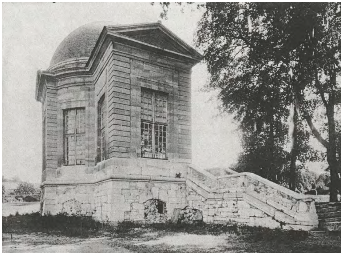
Fig. 40 : Vue de l'arrière du pavillon vers 1925 - Cliché NUM_PH_92330_60 - Coll. Domaine départemental de Sceaux
