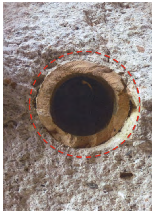
Fig. 64 : Photo de détail montrant la fine couche de mortier assurant l'assemblage des tuyaux - Figure 21 extraite de l'article : GAZAGNE et alii , « Adduction, évacuation et gestion de l'eau dans l'enclos du Temple de Paris : approches archéologiques et techniques », Archéologie Médiévale , n° 47, 2017 © S. Büttner/CEM
