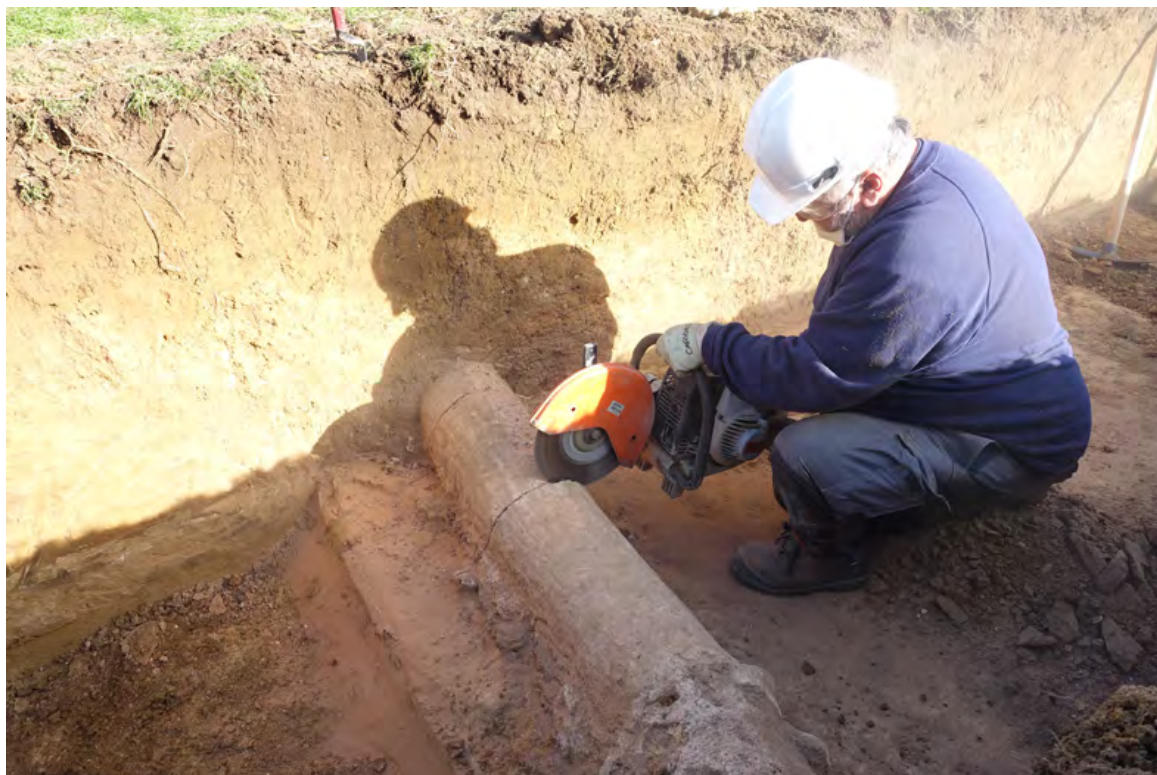
Fig. 59 : Découpe à la meuleuse de la canalisation St 1 mise au jour dans le sondage S.1 © C. Travers
