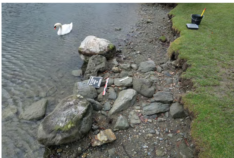
fig. 26 : Maçonnerie M6 observée le long de la rive est © Archéoverde
