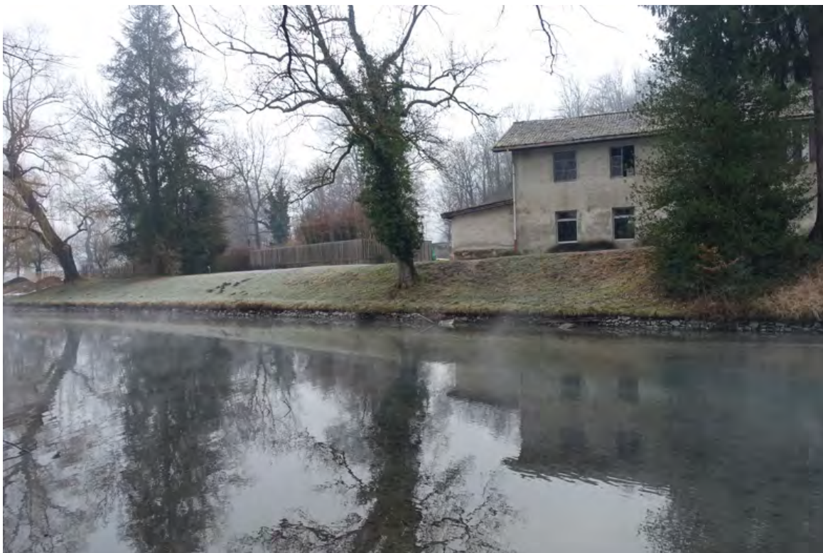
fig. 19 : Mur de la pièce d'eau XIXe encore en place sur la rive est © Archéoverde
