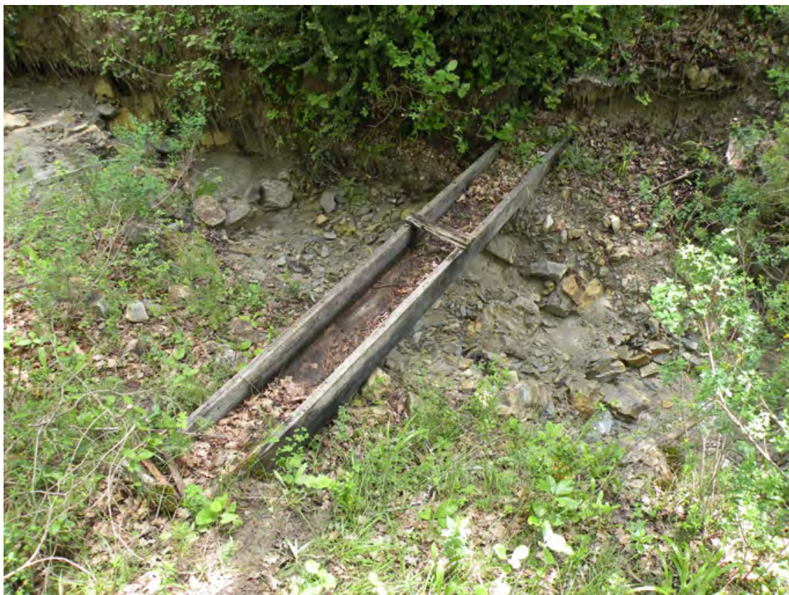
fig. 15 : Aqueduc en planches pour l'irrigation, au passage d'un ravin, commune d'Ubraye © Région Provence-Alpes-Côte d'Azur - Inventaire général
