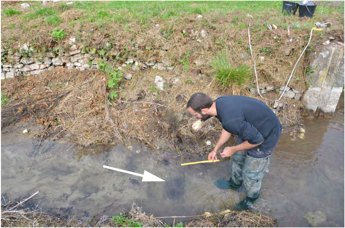
fig. 5 : Dormant en bois du batardeau amont - © C. Travers
