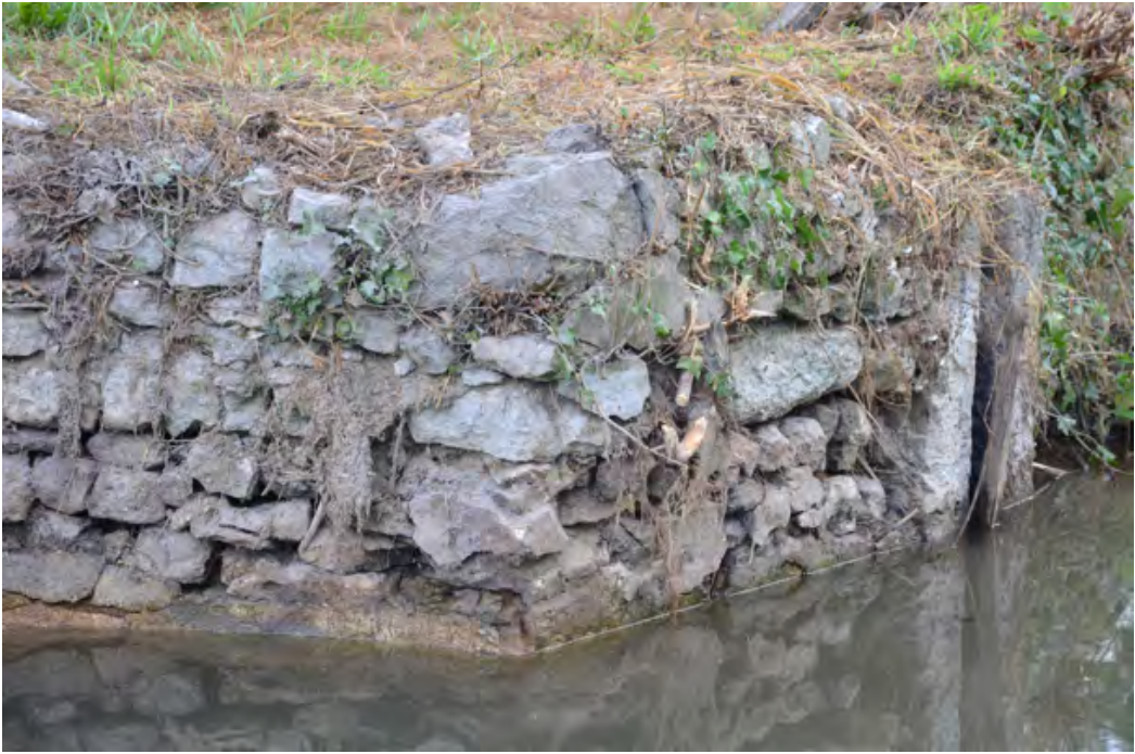
fig. 2 : Rainure verticale du système de vannage aval, perpendiculaire à l'axe du bassin - © C. Travers
