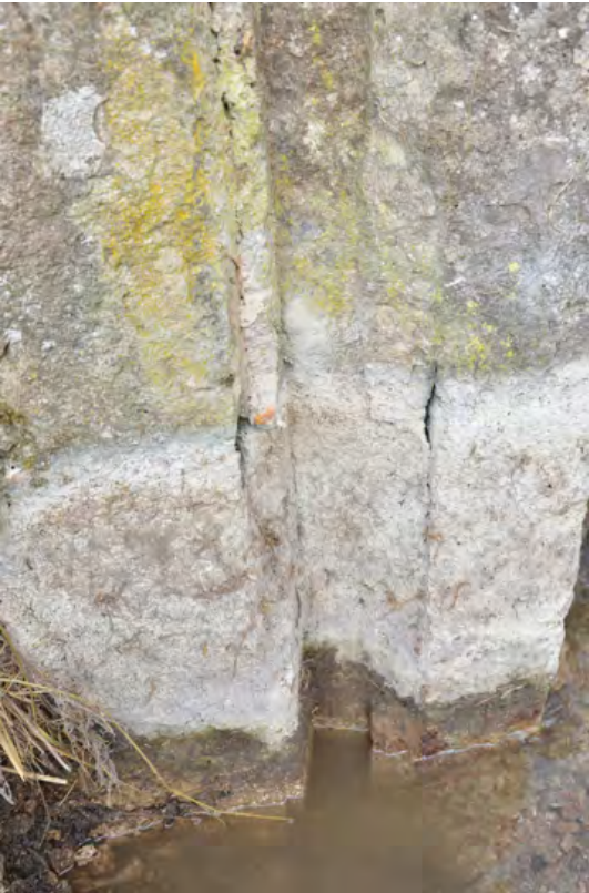
fig. 3 : Rainure verticale et braise du système de vannage amont et son enduit de mortier hydraulique - © C. Travers
