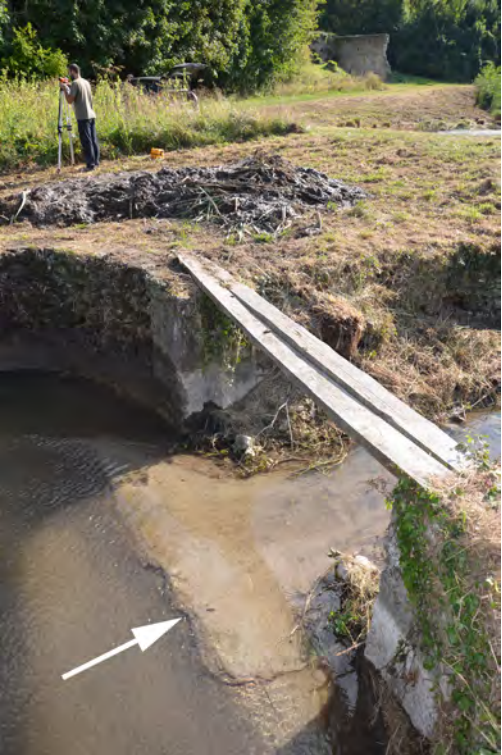
fig. 6 : Premier mur de chute de la porte amont - © C. Travers
