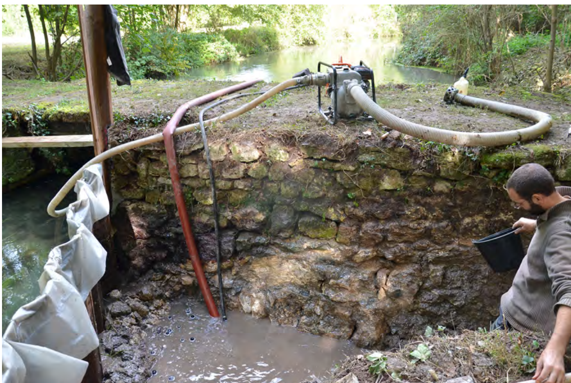
fig. 36 : Fondation du Pont Gris observée dans le sondage S.IX - © C. Travers
