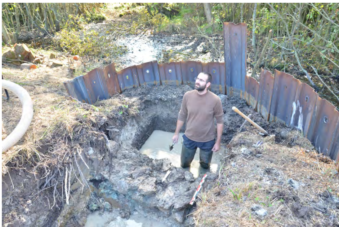
fig. 3 : Palplanches métalliques plantées sur l'emprise du Grand Lac au niveau du sondage S.III - © C. Travers
