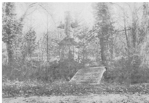
fig. 26 : Passerelle cintrée reliant la rive gauche de la Juine à l'Île dite de la Colonne Rostrale - Documentation Société Historique et Archéologique du Sud-Essonne (photocopie aimablement fournie par B. Binvel)
