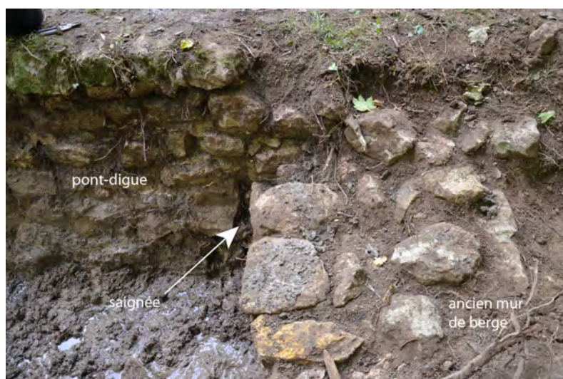
fig. 33 : Le mur de berge rive droite état 2 observé dans le sondage S.IX - © C. Travers
