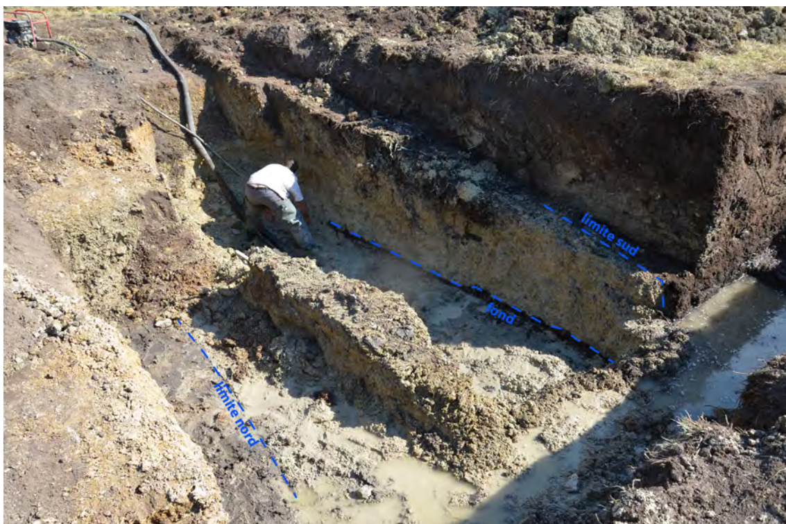
fig. 57 : Vue générale des limites de la tranchée observée dans le décapage est du sondage S.XIX - © C. Travers
