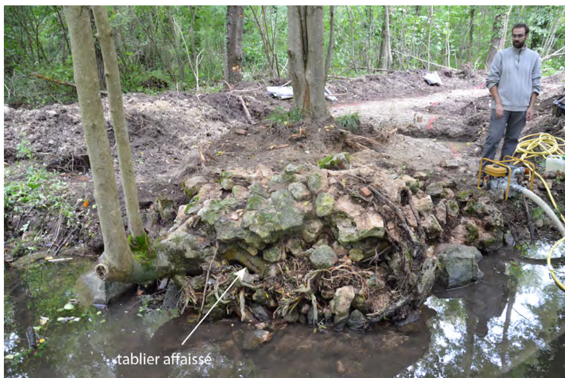
fig. 79 : L'amorce du pont de la rive droite, vue de face - © C. Travers
