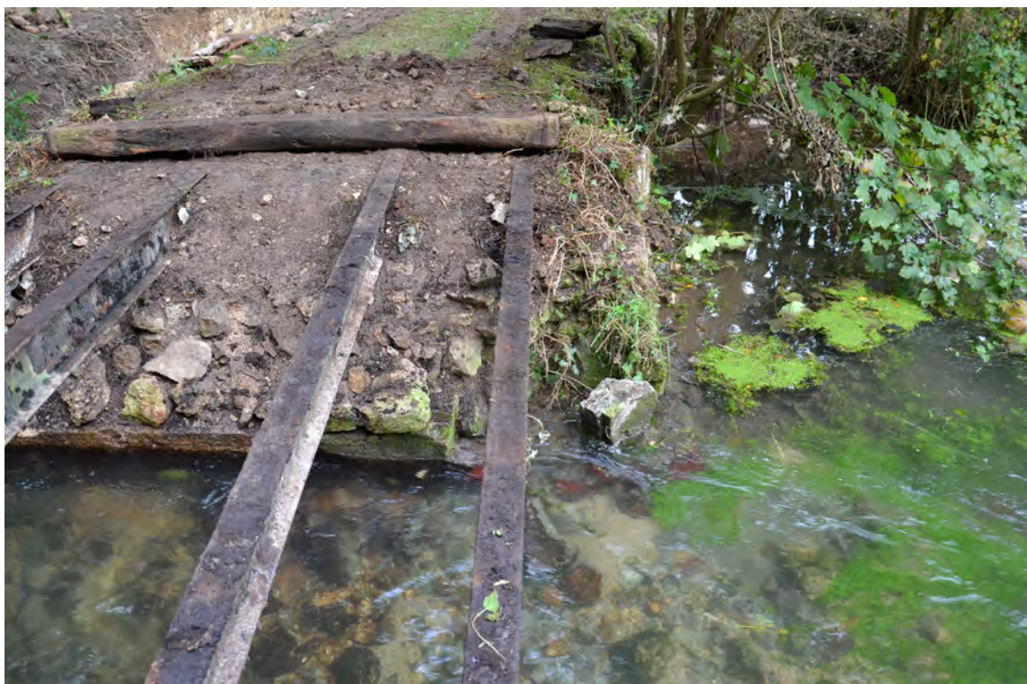
fig. 37 : Tablier du Pont Gris en cours de dépose - © C. Travers
