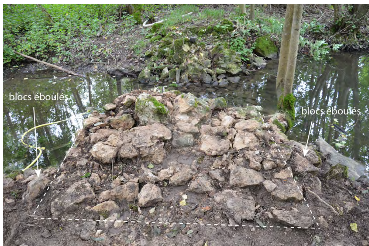
fig. 80 : L'amorce du pont de la rive droite, vue de dessus - © C. Travers
