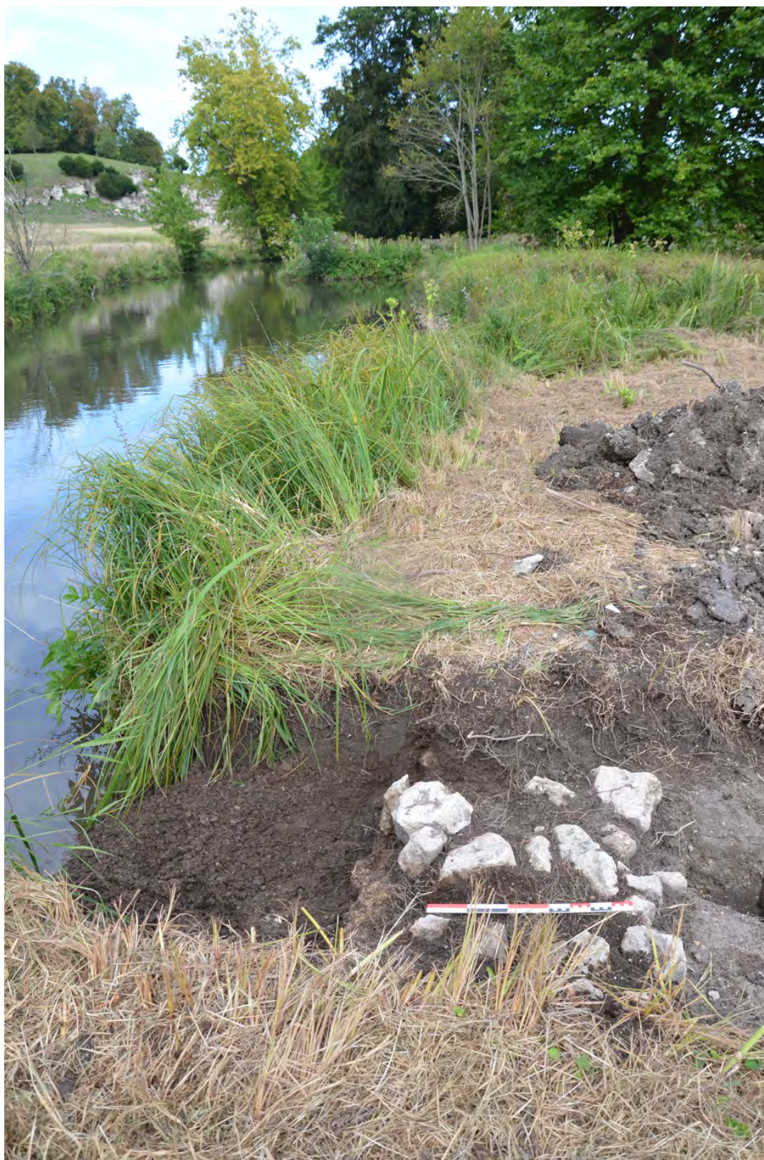
fig. 49 : Le mur de berge de rive droite observé dans le sondage S.XIV - © C. Travers
