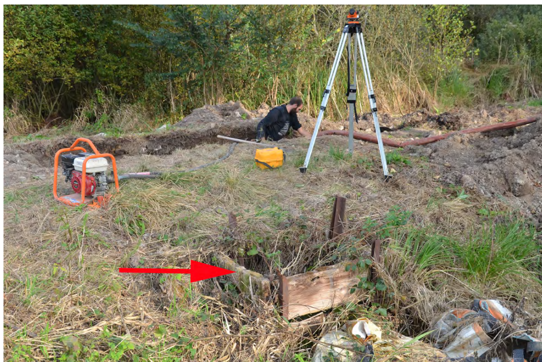
fig. 14 : Seuil à batardeau où débouche la buse observée dans S.XII - © C. Travers
