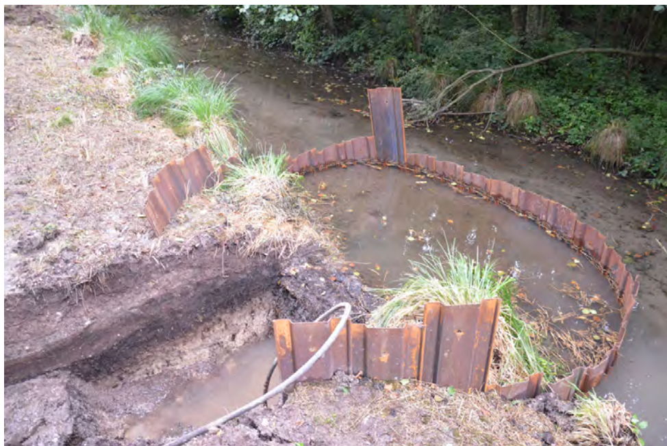
fig. 75 : Le sondage S.XXII et son blindage - © C. Travers
