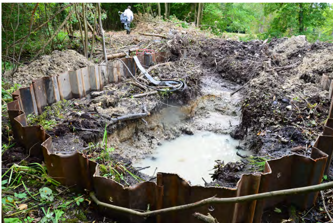
fig. 19 : Le blindage de palplanches du sondage S.XVII - © C. Travers
