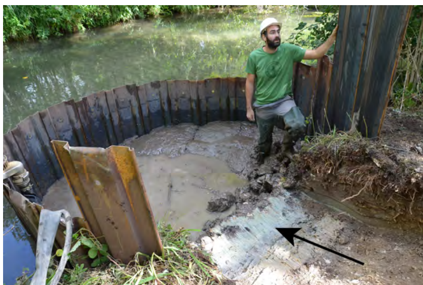
fig. 51 : Apparition du corroi d'étanchéité du mur de berge US 135 lors du creusement du sondage S.XV - © C. Travers
