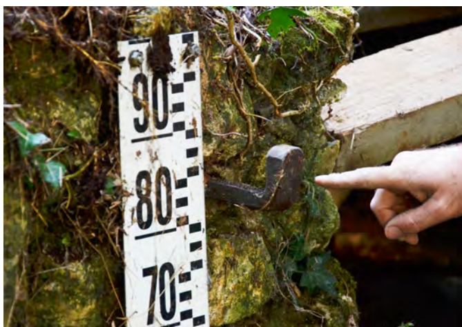
fig. 38 : Patte de fixation de vanne scellée au ciment dans le massif d'angle sud-ouest de l'ouverture centrale du Pont Gris - © C. Travers
