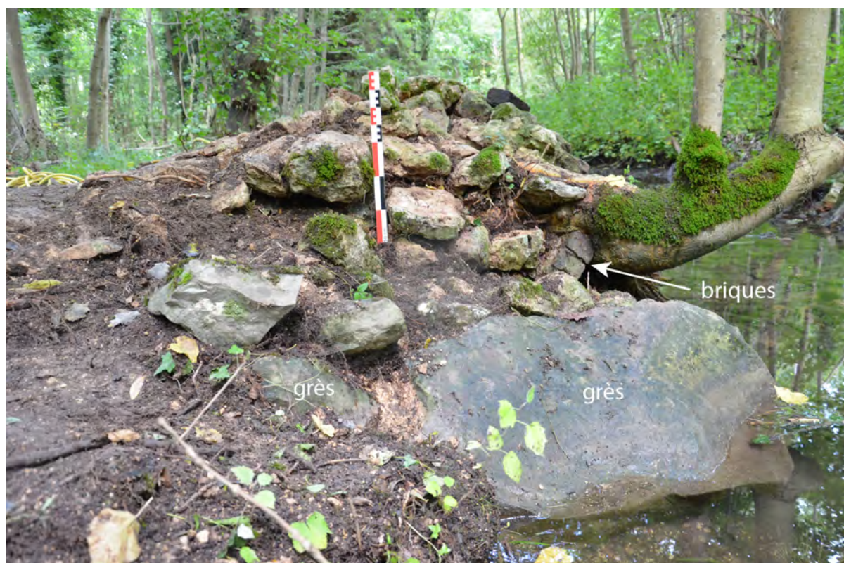
fig. 81 : L'amorce du pont de la rive droite, vue du côté ouest - © C. Travers
