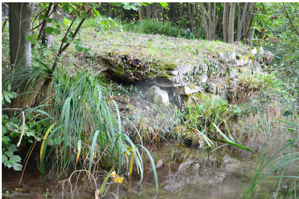
fig. 71 : Les vestiges du Pont du Petit Lac situés en rive droite de la Rivière anglaise, vus du nord - © C. Travers
