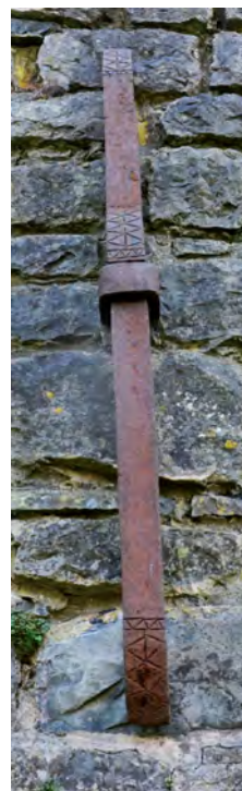
fig. 85 : L'une des ancrs du mur du potager de Freÿr © C. Travers
