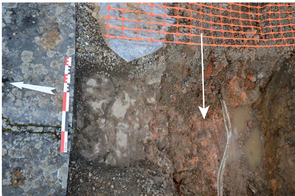
fig. 62 : Présence d'une maçonnerie associant des blocs calcaires et des briques liés au mortier rouille type US 113/114 à l'arrière du mur de douve du bassin ovale actuel © C. Travers
