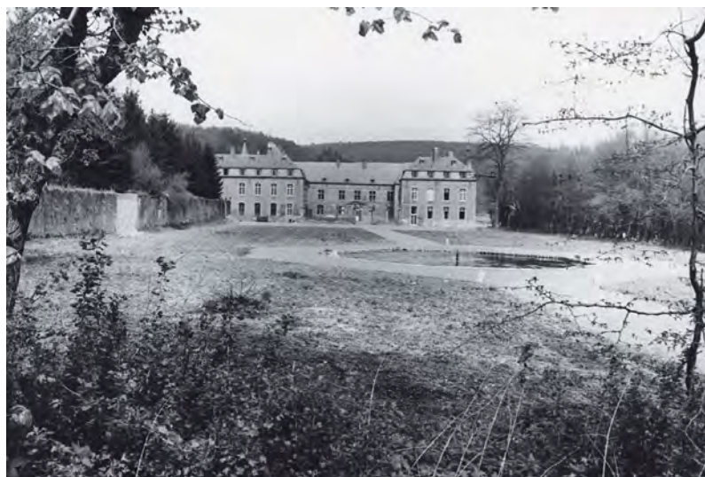
fig. 32 : Vue du jardin sud en 1972 - © F. Bonaert
