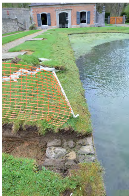
fig. 68 : Le mur de douve du bassin B2 après dégagement du glacis de pelouse © C. Travers
