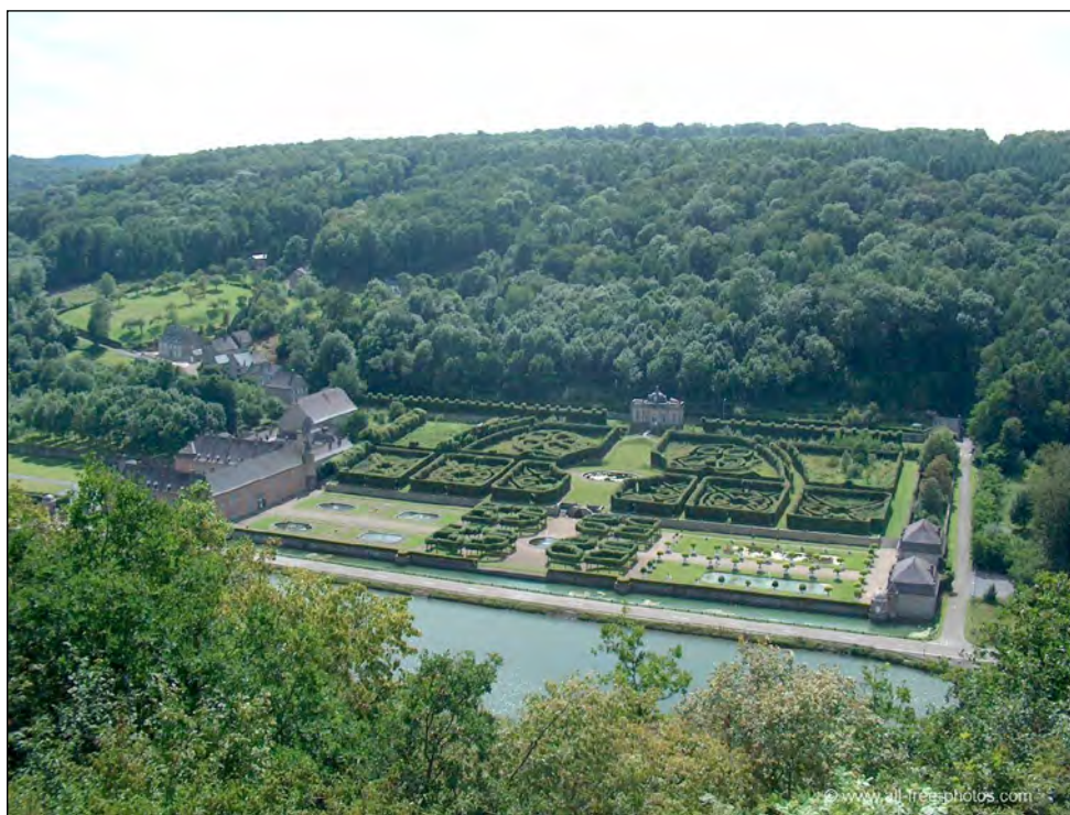
fig. 2 : Vue aérienne des jardins de Freÿr depuis la rive droite de la Meuse
