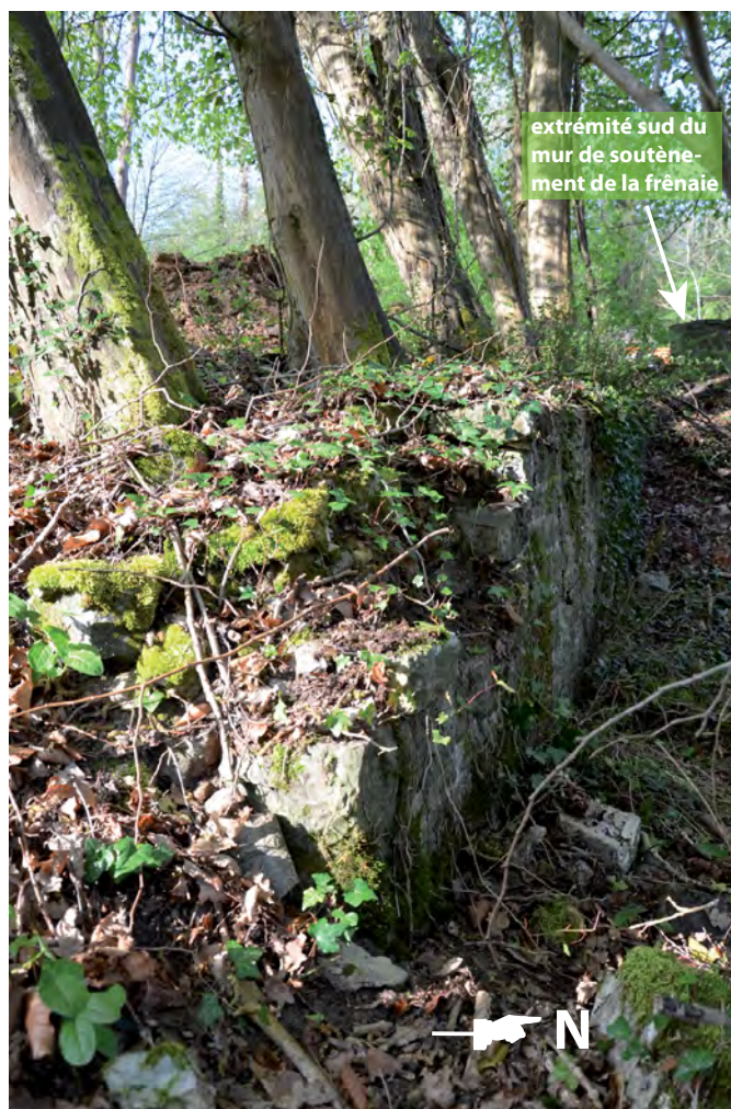
fig. 43 : Mur de soutènement sud, jardin sud © C. Travers
