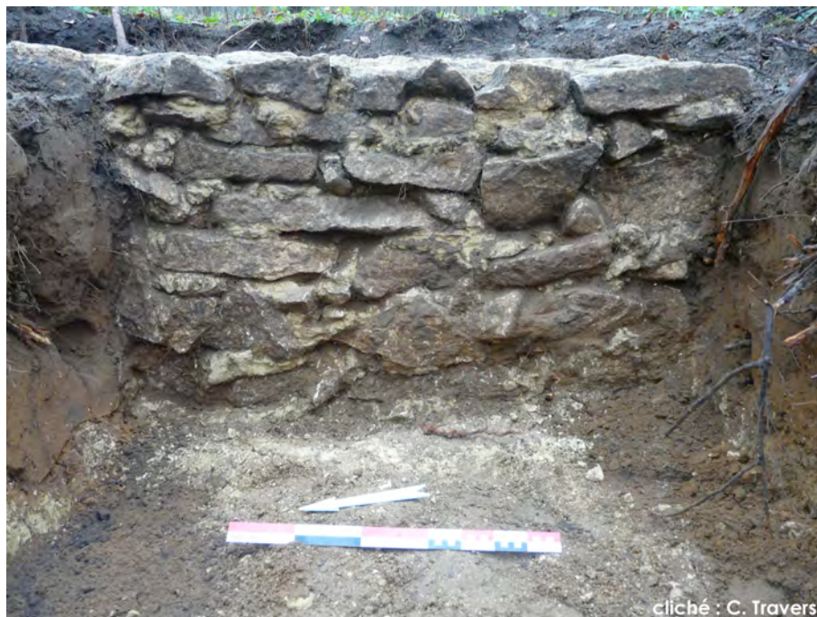
fig. 25 : Fondation du socle de la Mort, face ouest (structure ST.7)
