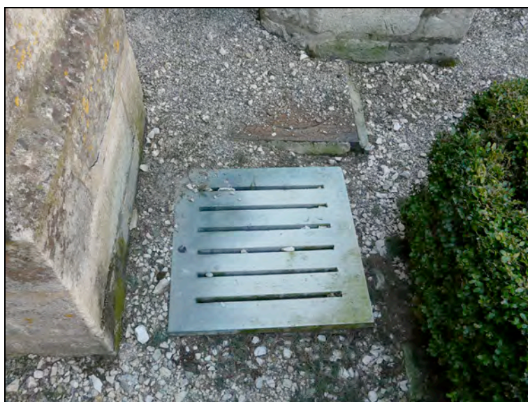
fig. 32 : Grille d'égout contemporaine située à l'aplomb des gargouilles du petit cloître de la chartreuse de Villeneuve-lès-Avignon (cliché : C. Travers)
