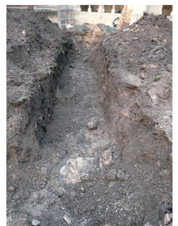
fig. 4 : Canalisation C.4 (cliché : C. Travers)
