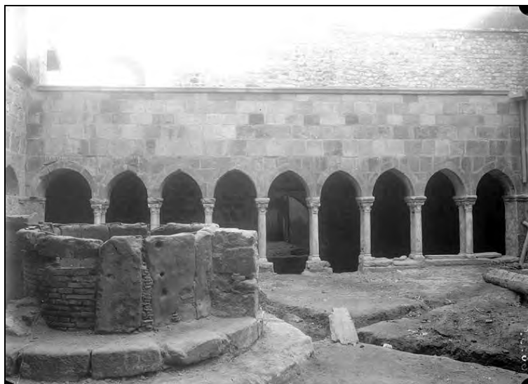
fig. 28 : Puits-citerne dans le cloître de la cathédrale de Fréjus (83), milieu du XIXe siècle - Cliché de E. GOETZ (photographe), s. d., Façades est et sud, vue extérieure, après restauration – © Ministère de la Culture – Médiathèque de l'architecture et du patrimoine – Diffusion RMN (source internet : www.culture.gouv.fr )
