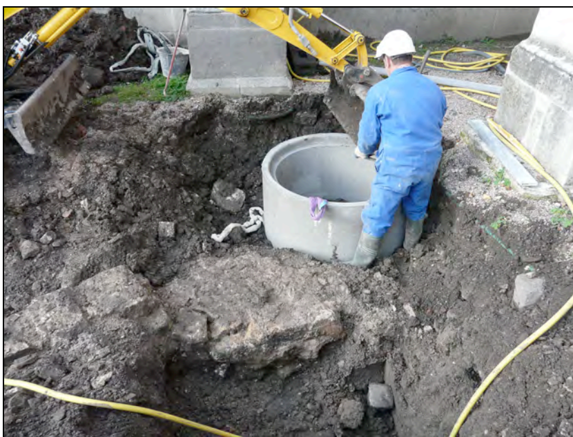
fig. 4 : Implantation d'une buse en ciment dans l'angle N/O du cloître (cliché : C. Travers)
