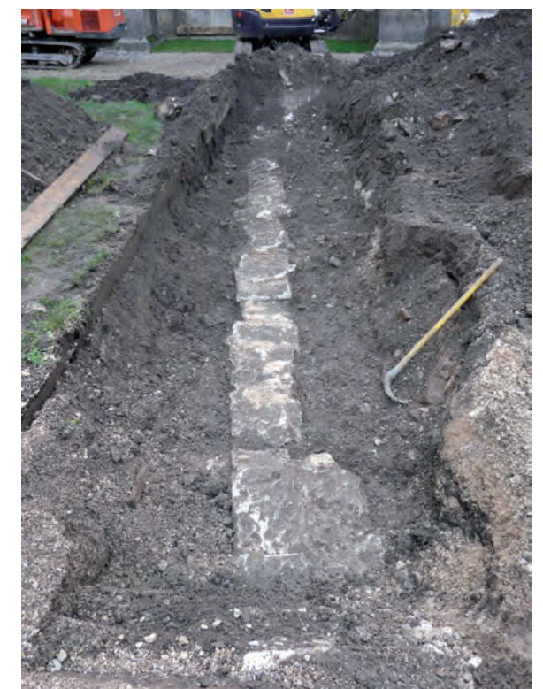
fig. 8 : Canalisation C.9 (cliché : C. Travers)
