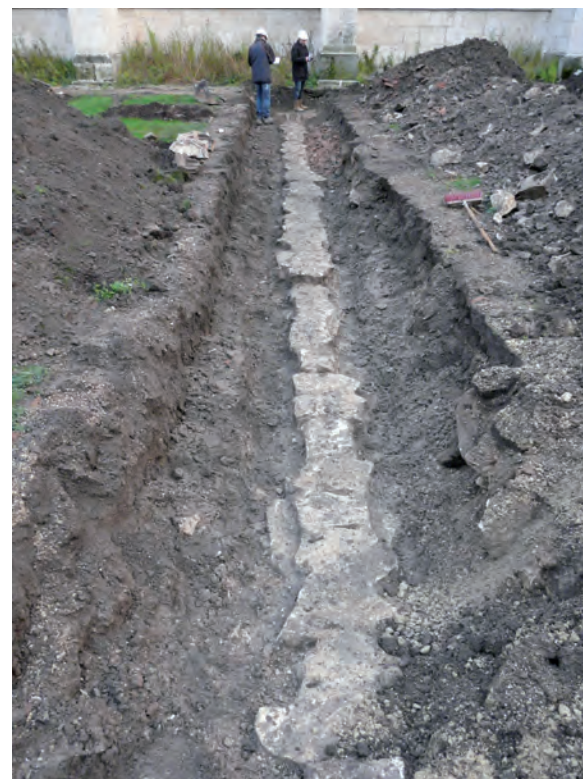
fig. 6 : Canalisation C.7 (cliché : C. Travers)
