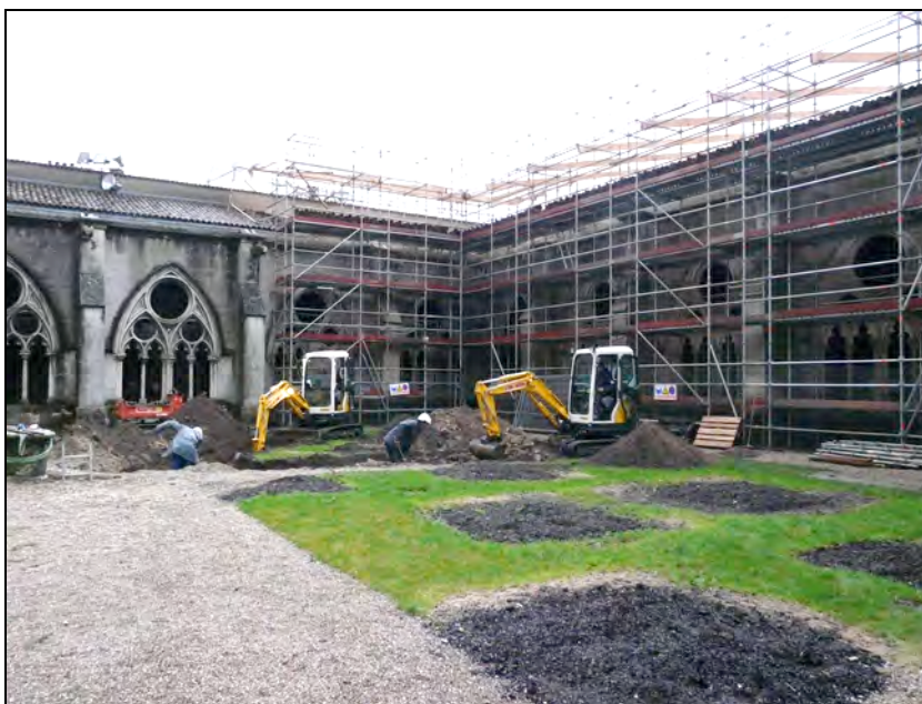
fig. 2 : Vue vers l'angle S/E du cloître, présence d'un échafaudage (cliché : C. Travers)
