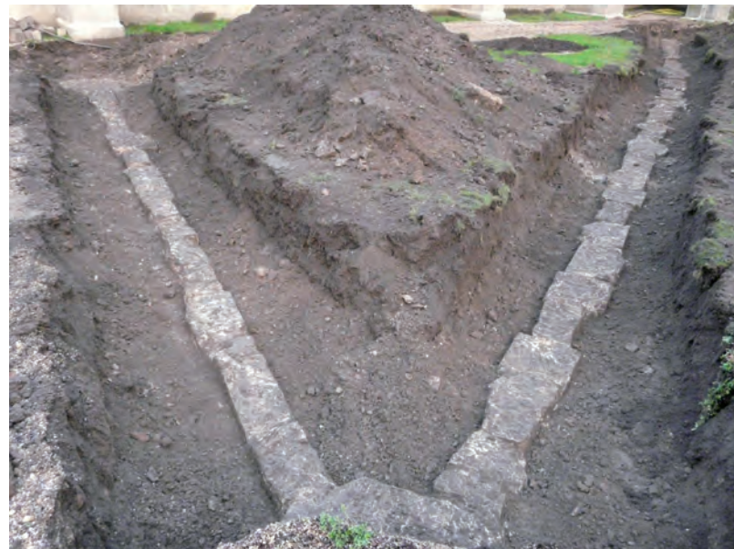
fig. 5 : Canalisations C.5 et C.6 (cliché : C. Travers)
