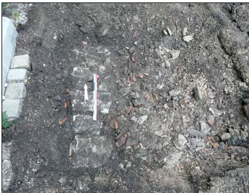
fig. 37 : Drain contemporain implanté sous l'allée périphérique du jardin, côté ouest (cliché : C. Travers)
