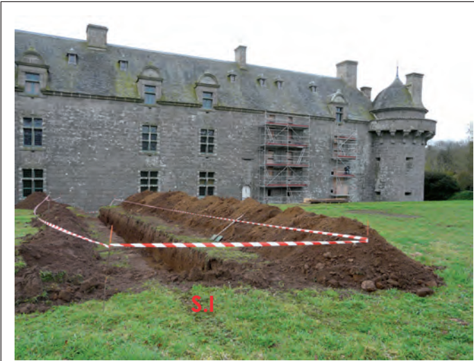
Vue du chantier depuis le nord
