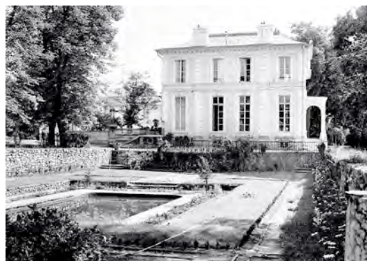
fig. 15 : Vue de la façade Nord de la Folie en 1961 5
