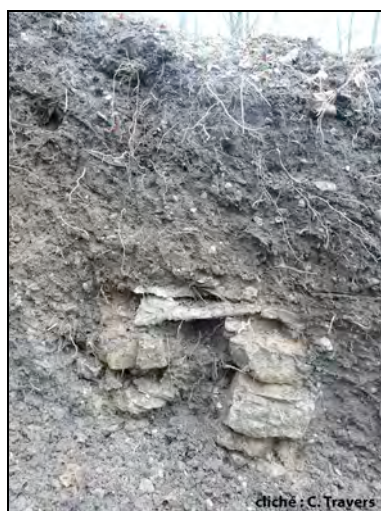
fig. 16 : Vestiges de l'aqueduc maçonné implanté à l'époque de Léopold à la base des talus Nord – Coupe stratigraphique S-N du sondage S.XXIV
