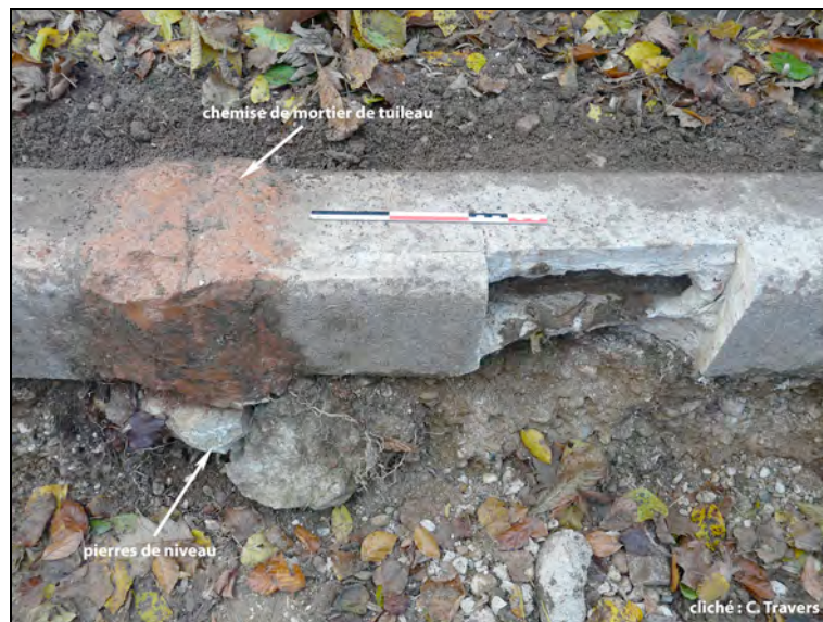
fig. 82 : Vue de détail de la canalisation en ciment XIXe - Sondage S.VIII
